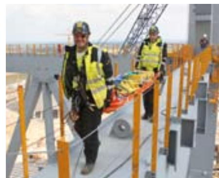
Rettungsübung: Höhenarbeiter proben den Ernstfall.
