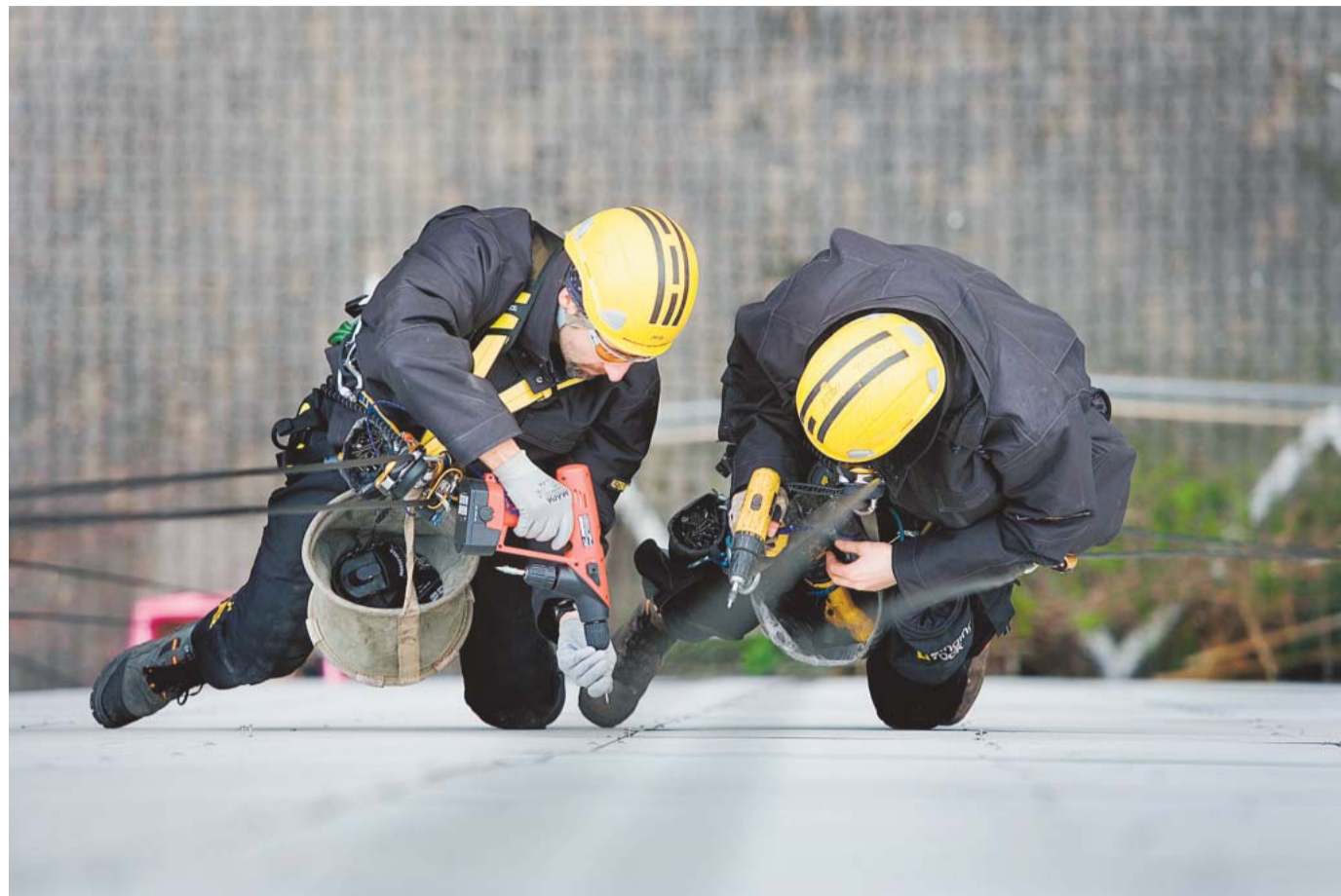
Schwindelfrei: Fassadenkletterer reparieren die Sozialstation in Bockenheim.
