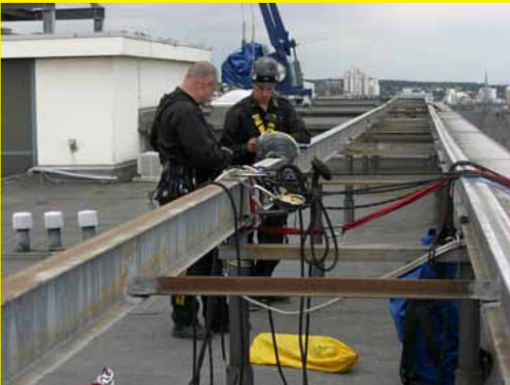
Letzte Überprüfung der Installationen
