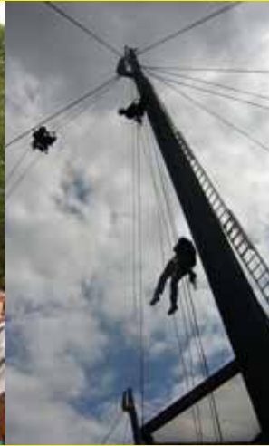
Installation der Seilbahn
